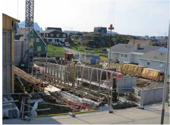
Byggeri af Tuulliit den 12. juli 2023.
