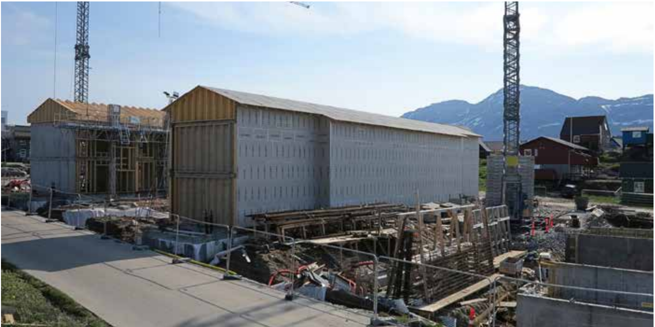
Byggeri af Tuulliit den 12. juli 2023.
