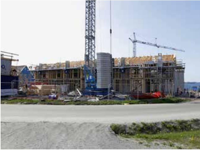
Byggeri af Tuulliit den 12. juli 2023.
